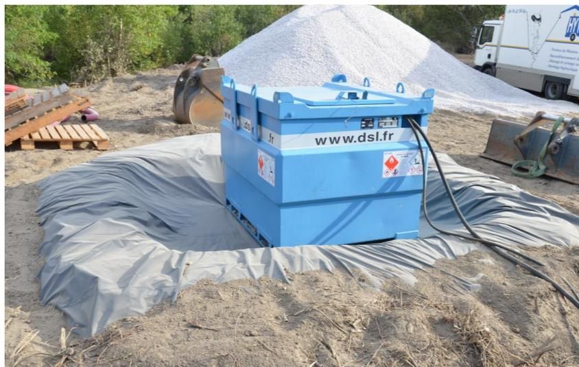
☞ Photographie 31 : Mise en place d'une aire étanche autour d'un groupe électrogène
