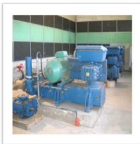
Contrôle des équipements électromécaniques d'apport d'air dans les bassins d'aération : les surpresseurs.
